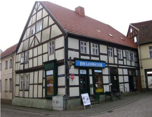
Fachwerkhaus (z. B. am Markt)
